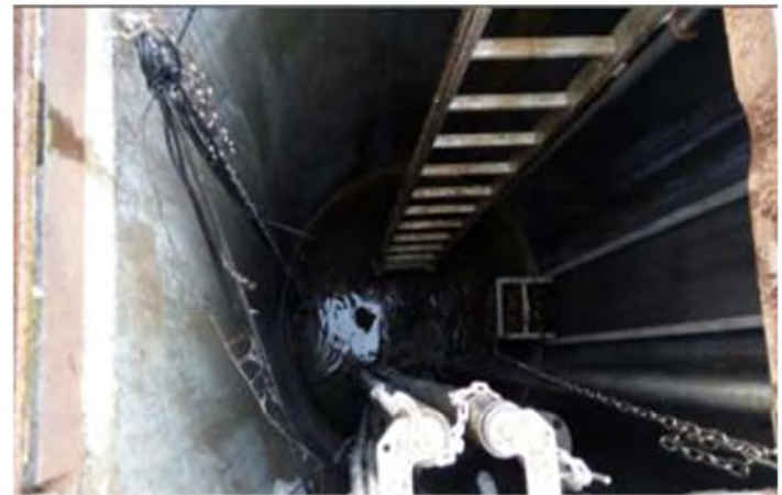
Chambre à vanne
