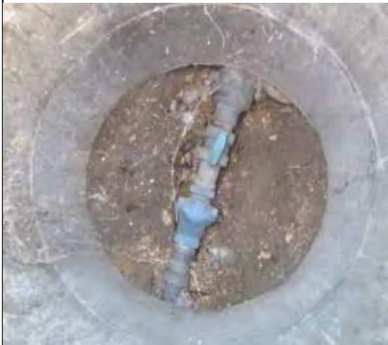
Chambre à vanne
