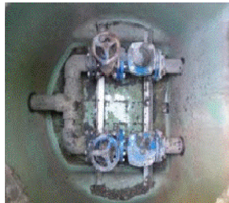
Chambre à vanne
