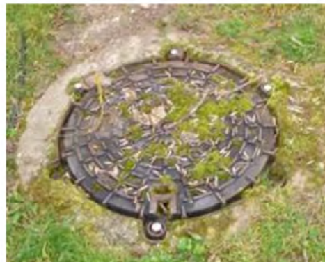
regard amont boulonné
