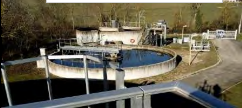
Vue générale de la STEP
