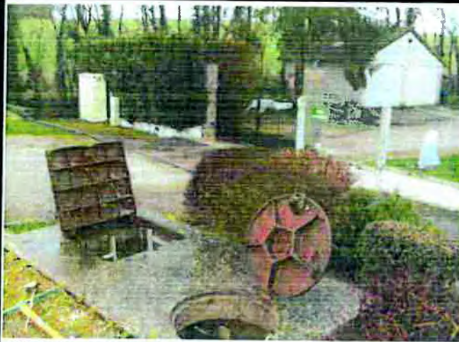
PR 4 : Vue d'ensemble
