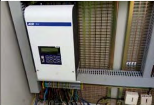
Démarreur électronique AOIp NOVADEMS3
