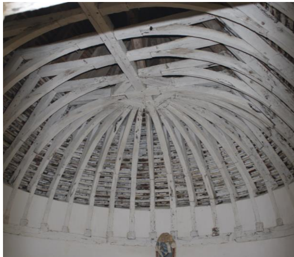
Charpente de la Chapelle
