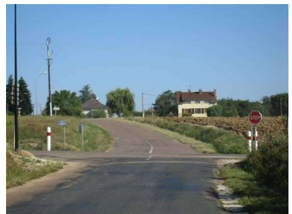
Croisement structurant de la voirie locale
