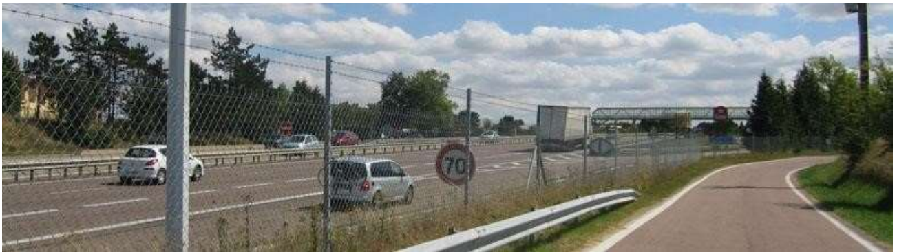
Voie de desserte le long de l'A6 (secteur Ouest) menant à l'aire d'autoroute Grosse Pierre
