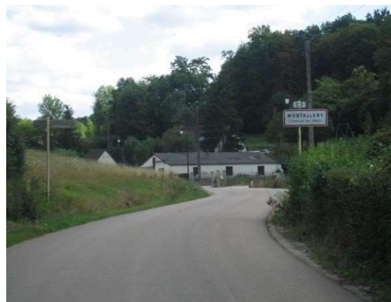
Entrée de ville Nord
