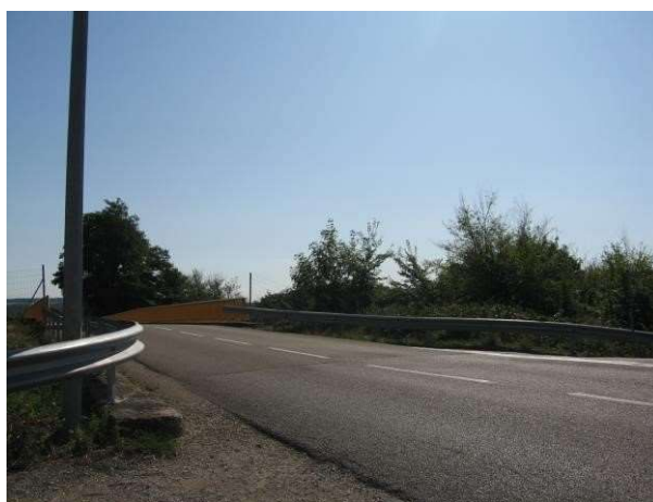
RD 124 - Franchissement de l'A6
