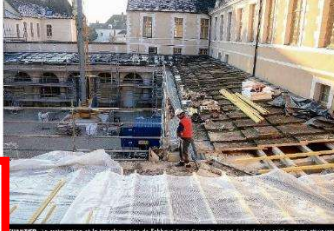
CHARRIER. La rénovation et la transformation de l'abbaye Saint-Germain seront évoquées en séance. (Archives locales)
