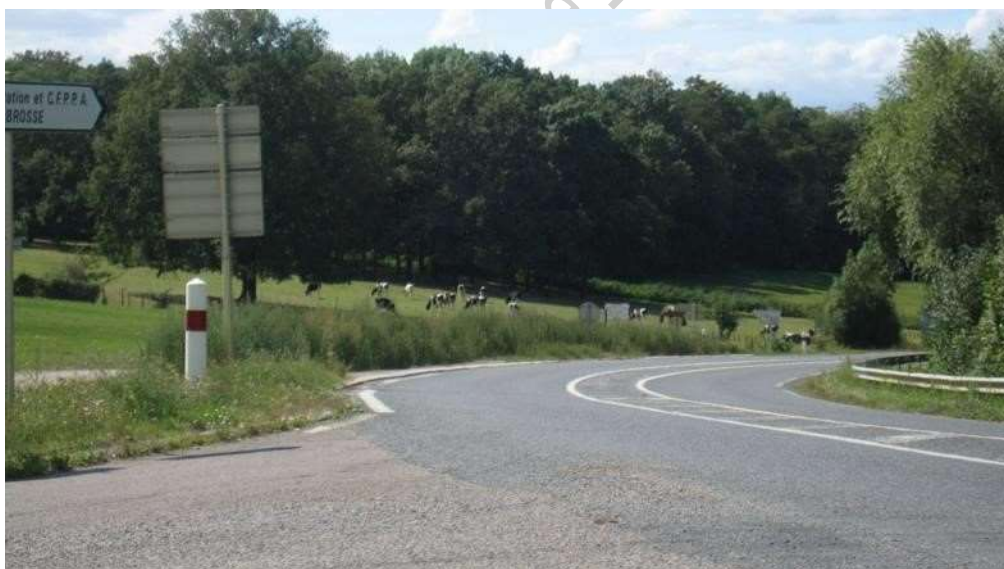
Croisement Rd965/accès au site
