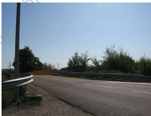
RD 124 - Franchissement de l'A6
