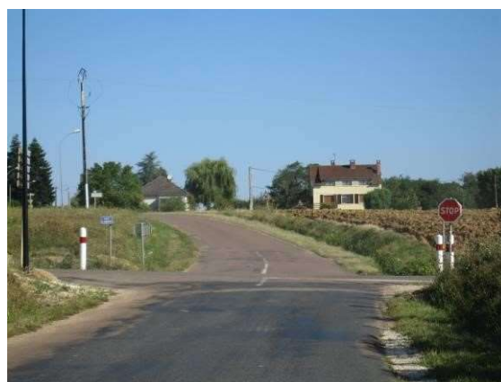
Croisement structurant de la voirie locale
