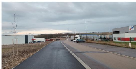
Photo prise de la route depuis la sortie de Venoy-Bourg par CD le 22 janvier 2023 : le zonage AUX est déjà partiellement construit (transport Yonne express.loubot et Idverde)
