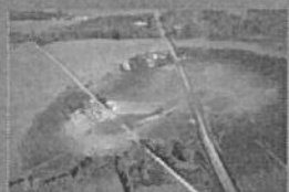
Conséquences d'une fuite sur une canalisation de transport, Apopatox (USA), 14 septembre 2008 (source pstrust.org).
