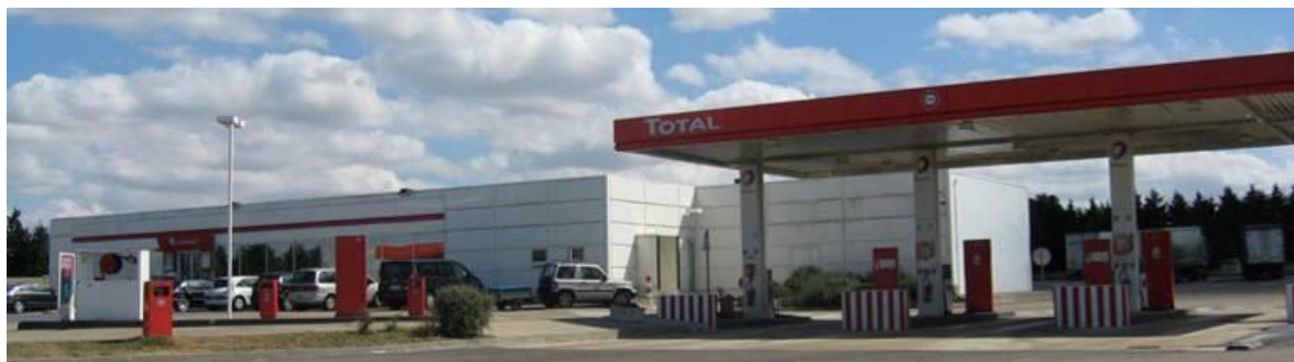
Station-service sur l'aire de la Grosse Pierre
