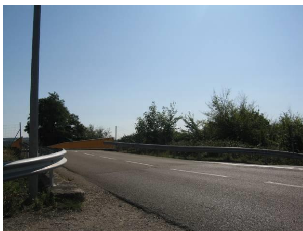
RD 124 - Franchissement de l'A6
