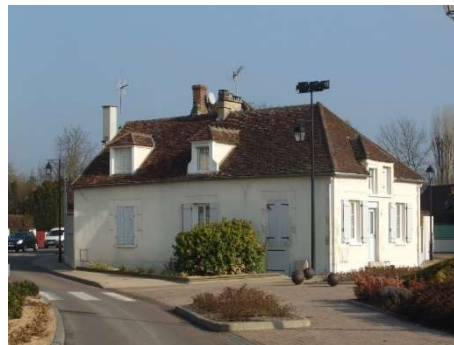
Des bâtiments de qualité et témoin de l'ancienneté du lieu
