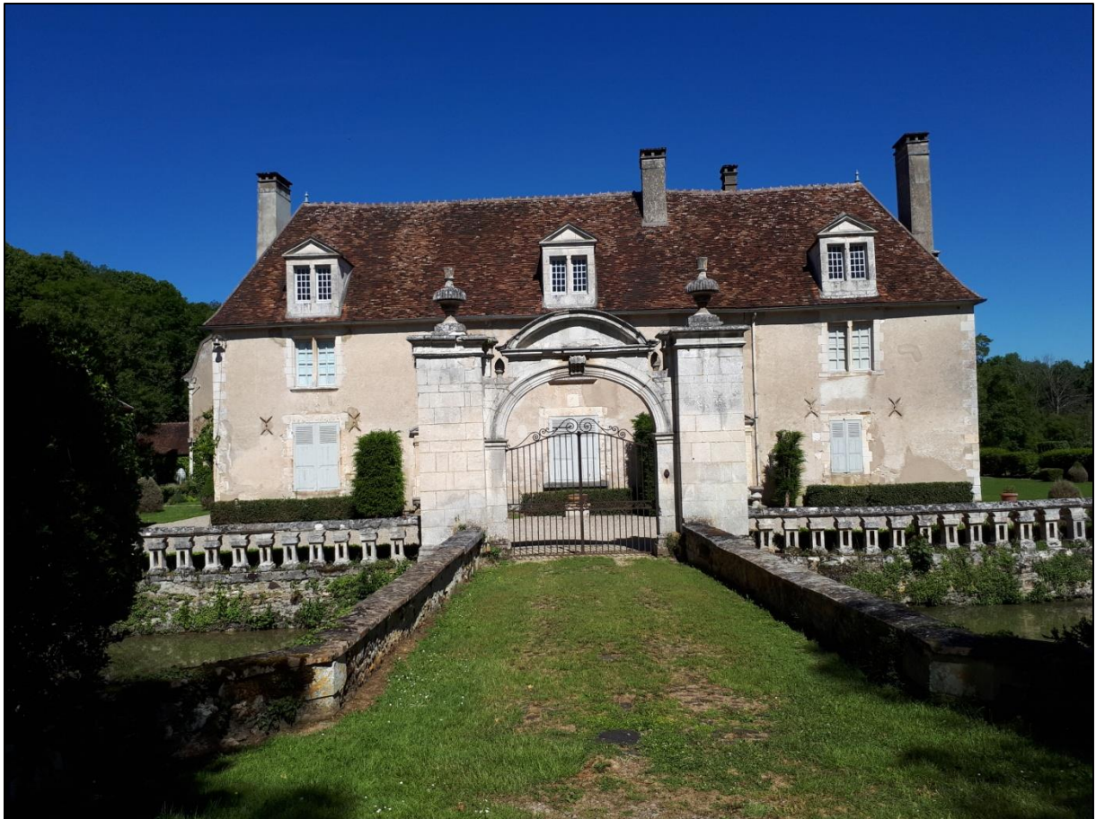
Figure 79 : photo du château d'Avigneau (source : CDHU)
