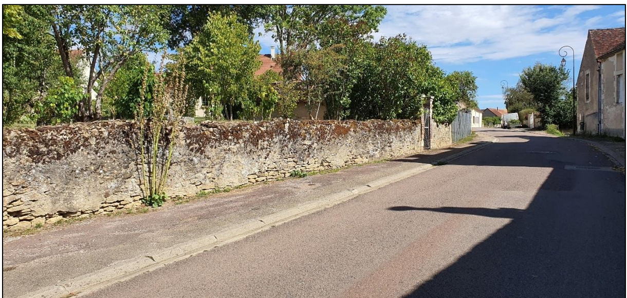
Figure 114 : Exemple de mur protégé au titre de l'article L151-19 (source : CDHU)
