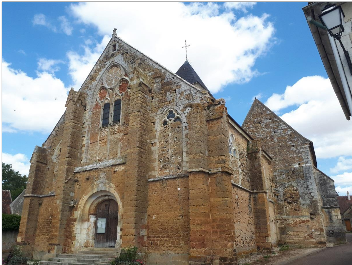
Figure 77 : photo de l'église Saint-Georges d'Escamps (source : CDHU)
