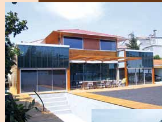
> Capteurs thermiques en façade (Chauffage)
