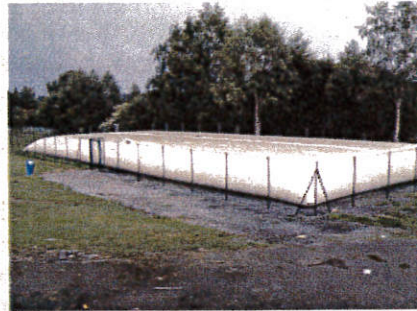
Citerne souple avec poteau d'aspiration
