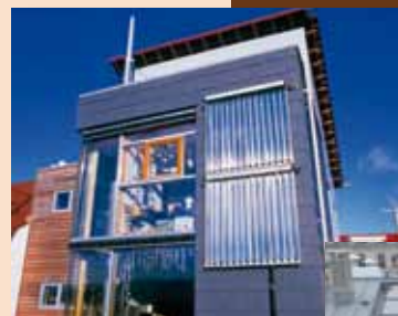
> Capteurs sous vide en façade
