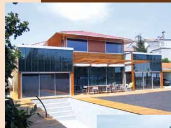
> Capteurs thermiques en façade (Chauffage)
