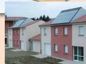
> Couverture totale en capteurs solaires thermiques (Chauffage)
