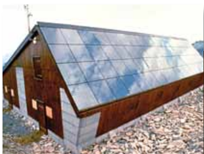
> Toiture complète en photovoltaïque
