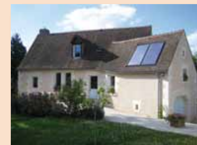
> Capteurs intégrés en toiture (CESI)
