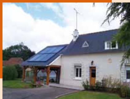
> Capteurs thermiques intégrés en toiture secondaire (Chauffage)
