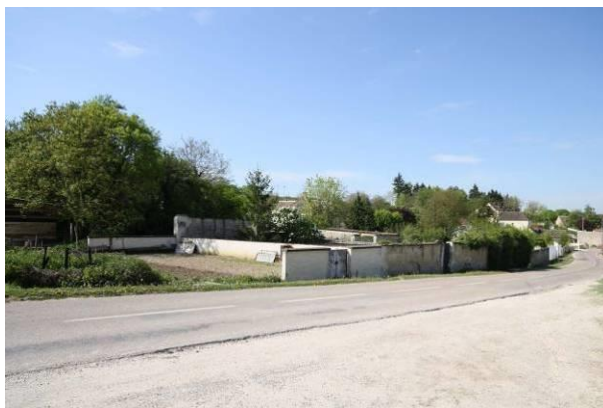
Paysage de l'entrée Est, partie Sud de la RD 38
