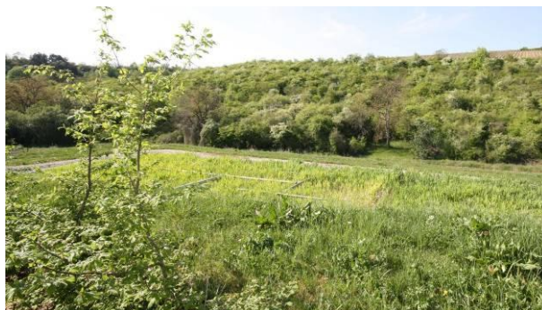
Les bassins de lagunage intégrés dans la pente
