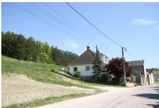
Une construction récente dans la pente, mais en retrait de l'alignement
