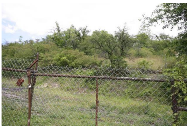
L'espace déjà défriché et « creusé » dans le coteau
