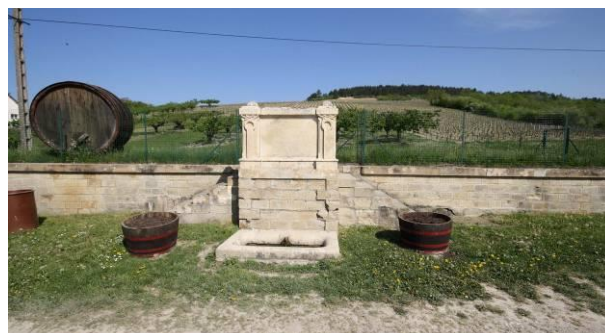
Réserve incendie face au cimetière
