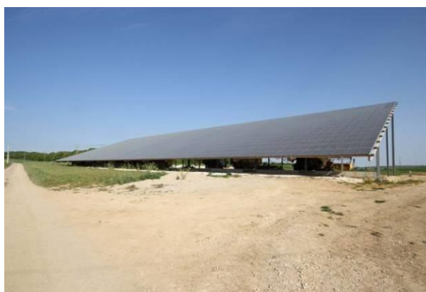
Le nouveau hangar recouvert de panneaux photovoltaïques
