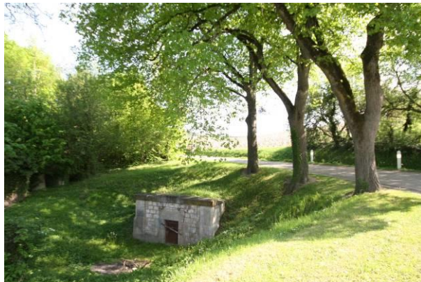
Station de pompage – entrée Est
