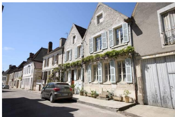
Le bâti ancien entretenu et mis en valeur
