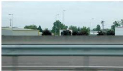
A Appoigny, une zone d'activités accolée à l'A6 et qui ne bénéficie d'aucun traitement qualitatif de sa façade tournée vers l'autoroute.
