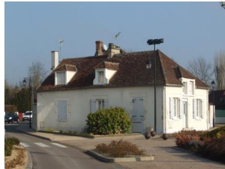
Des bâtiments de qualité et témoin de l'ancienneté du lieu
