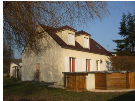
Des constructions d'architecture traditionnelle
