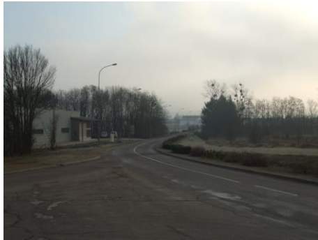
La ripisylve du ru de Baulche qui forme une frange de qualité avec l'habitat
