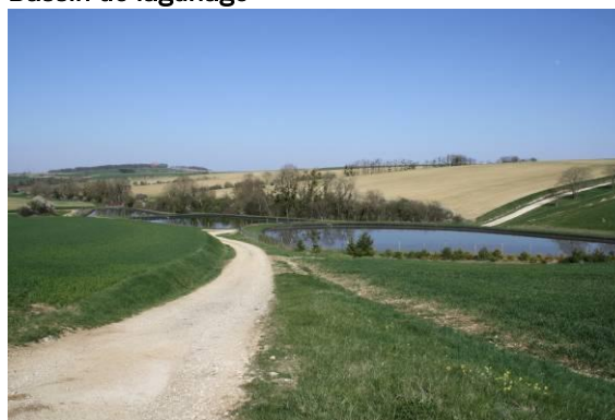
Bassin de lagunage
