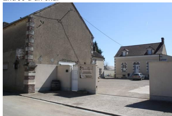
Entrée d'un chai
