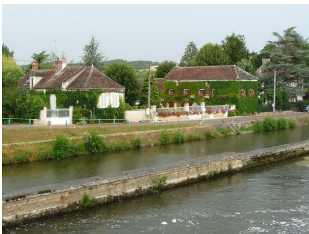
La façade fluviale de la Cour-Barrée rappelle la nature de l'agglomération : un lieu de traverse puis un port
