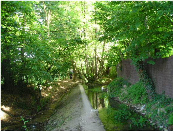
Barrage sur le ru à Vallan pour l'irrigation
