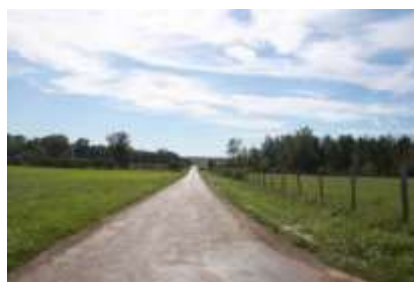
Route secondaire en milieu agricole reliant les Groseilliers à la Barcelle
