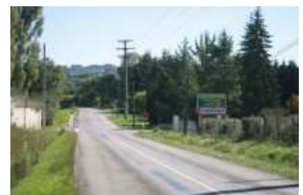
Intersections de routes secondaires avec la RD 31 aux Groseilliers
