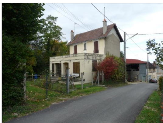
Mur bahut surmonté d'un dispositif à claire-voie
