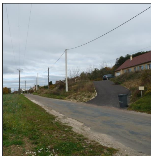
Accès facile à la propriété pour un stationnement en dehors de la voie publique
