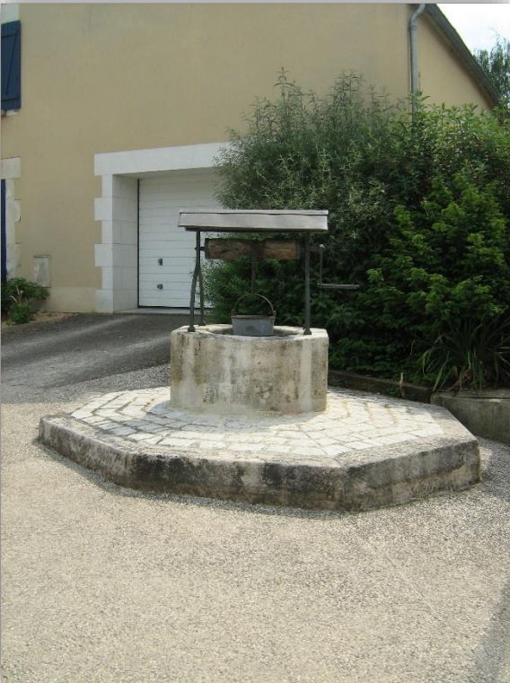
Photo 13 : puits et pompes à eau
