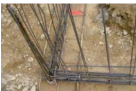
Nœud de chaînage - Continuité mécanique
