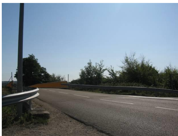
RD 124 - Franchissement de l'A6
