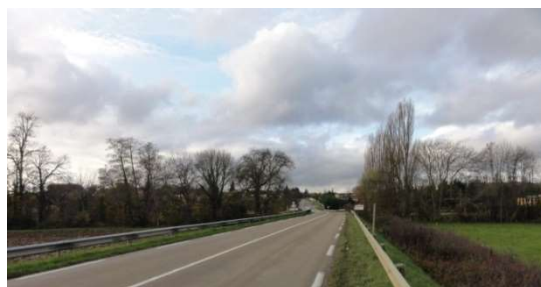
Entrée Est par la RD 965 en arrivant d'Auxerre - La végétation qui accompagne le Baulche joue un rôle important car elle forme un filtre qui atténue l'impact du bâti.
