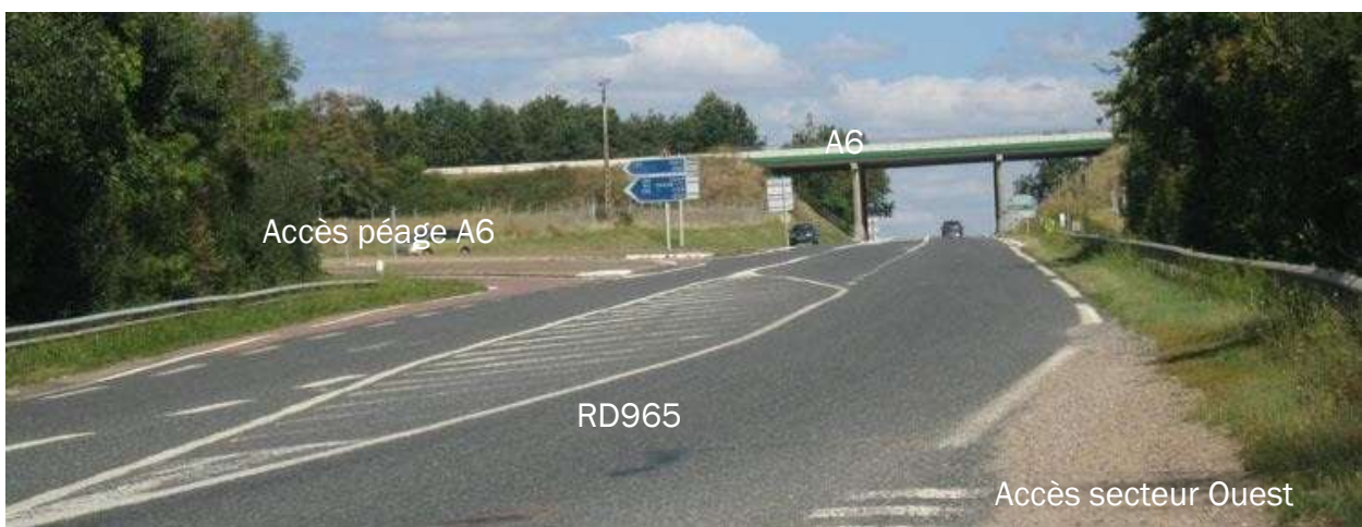
Vue depuis la RD965 au croisement avec la voie de desserte au secteur Ouest et vers l'aire d'autoroute Grosse Pierre
