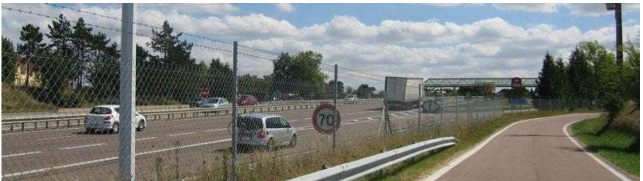
Voie de desserte le long de l'A6 (secteur Ouest) menant à l'aire d'autoroute Grosse Pierre
