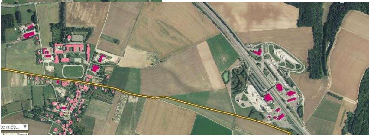
Le lycée agricole et l'aire d'autoroute
