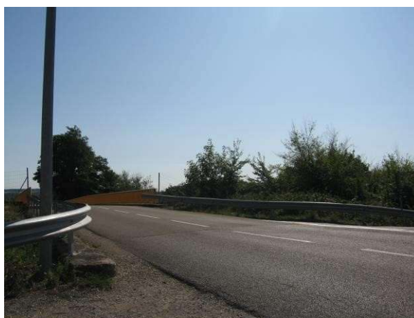
RD 124 - Franchissement de l'A6
