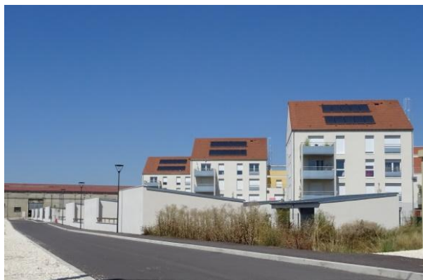
Panneaux solaires dans le résidentiel
