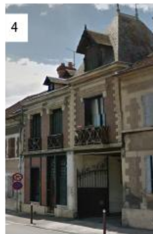
Localisation : rue du Bourneuil
