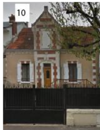
Localisation : avenue Pasteur
