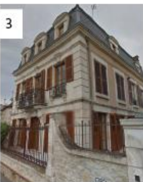
Localisation : rue Saint-Martin les Saint-Mariens Descriptif : maison bourgeoise avec une dépendance.
