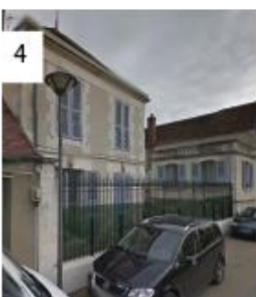
Localisation : rue Saint-Martin les Saint-Mariens Descriptif : maison bourgeoise avec une dépendance.
